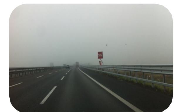
Barriera H3 bordo rilevato ultimata
