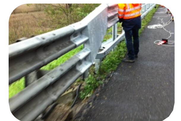
Particolare raccordo con barriera esistente
