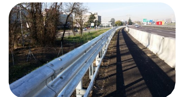
Installazione triplaonda CARH3BL3-S
