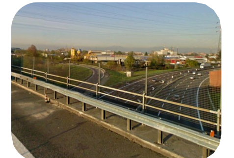
Margine esterno (bordo opera) protetto con barriera doppia onda semplice o sovrapposta
