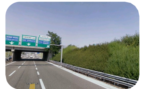
Doppia onda sovrapposta in trincea
