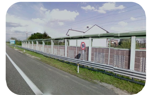
Barriera acustica con sicurvia tripla onda
