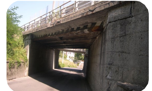
Svincolo Serravalle Scrivia – Ponte ramo direzione Genova
