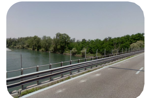
Ponte fiume Po – carreggiata nord
