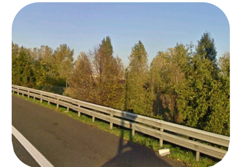
Margine esterno (rilevato) protetto con barriera doppia onda semplice o sovrapposta
