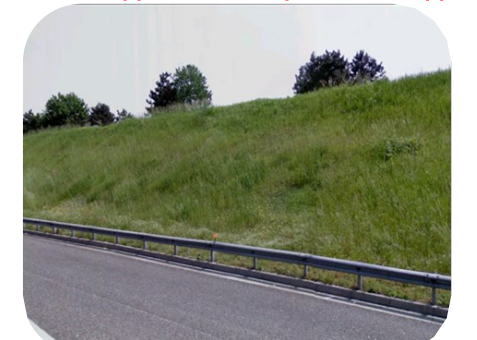
Margine esterno (trincea) protetto con barriera doppia onda semplice o sovrapposta
