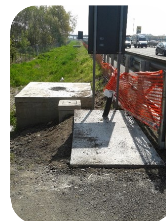
Realizzazione basamenti delle nuove posizioni delle colonnine SOS
