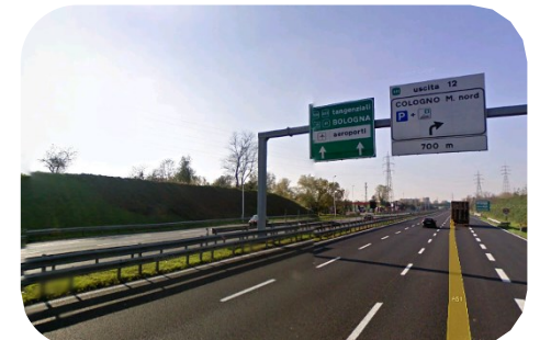
Spartitraffico centrale doppia onda semplice - sovrapposta
