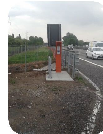
Realizzazione basamenti delle nuove posizioni delle colonnine SOS
